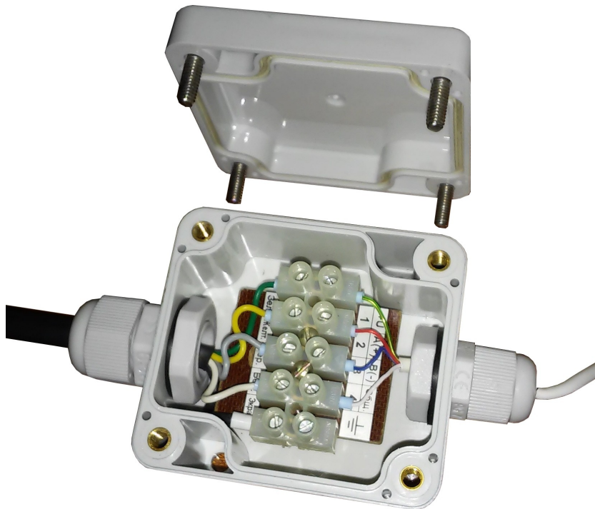
Рисунок D.1 - Клеммная коробка
